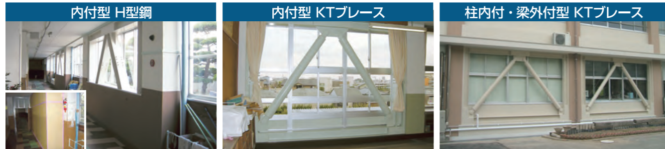
▲ 施工風景 (内部は使用しながら施工)
